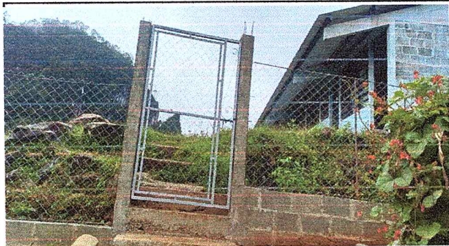
Foto 3: SUSTITUCION DE PUERTAS DE ENTRADA DE ESCUELA
