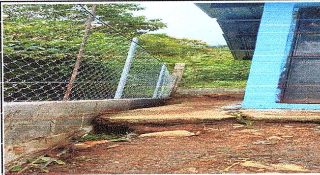
Foto 1: TERMINACION DE COLOCACION DE MURO PERIMETRAL
