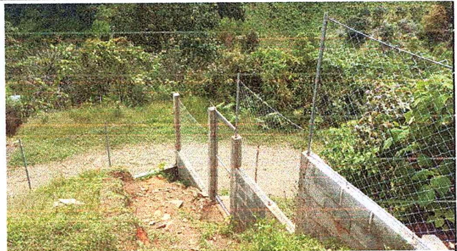
Foto 2: CULMINACION DE COLOCACION DE MURO PERIMETRAL
